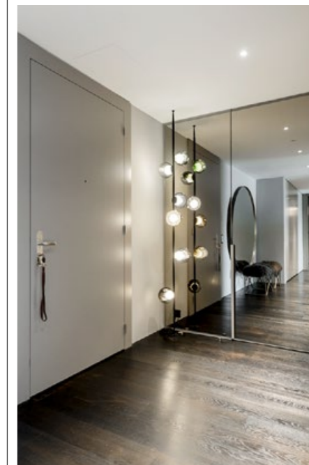
Hinter diesen Türen im Eingangsbereich versteckt sich die gesamte Haustechnik. Dank dem Trick mit den Spiegelfronten wirkt das Entrée grösser, und die Lampen von Bocci bilden attraktive Reflexionen in diesem sonst dunklen Bereich der Wohnung.
